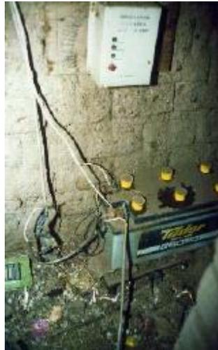
*Figura 26. Puenteo al regulador en instalación en Bolivia [TDPD].*
