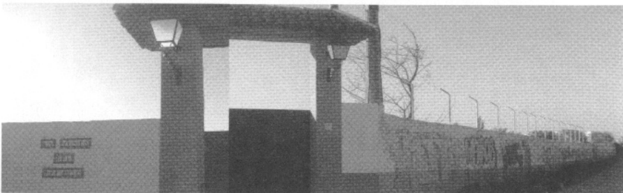
Portón de entrada a la finca con graffitis en las paredes.
