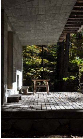
Figura 59. Porche de entrada que utiliza la relación interior-exterior del estilo sukiya, contrastando con el hormigón armado de la fachada y la extensión del alero.
