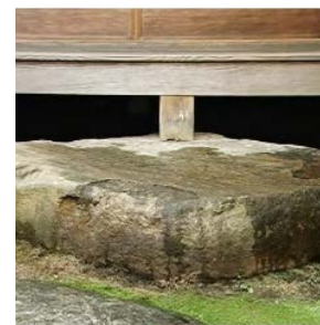
Figura 41. Cimentación sobre piedra semienterrada.
