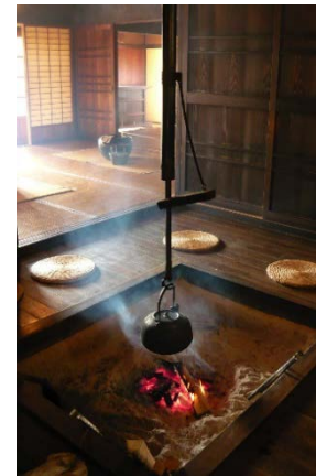
Figura 11. Irori tradicional rehundido sobre el suelo de madera.
