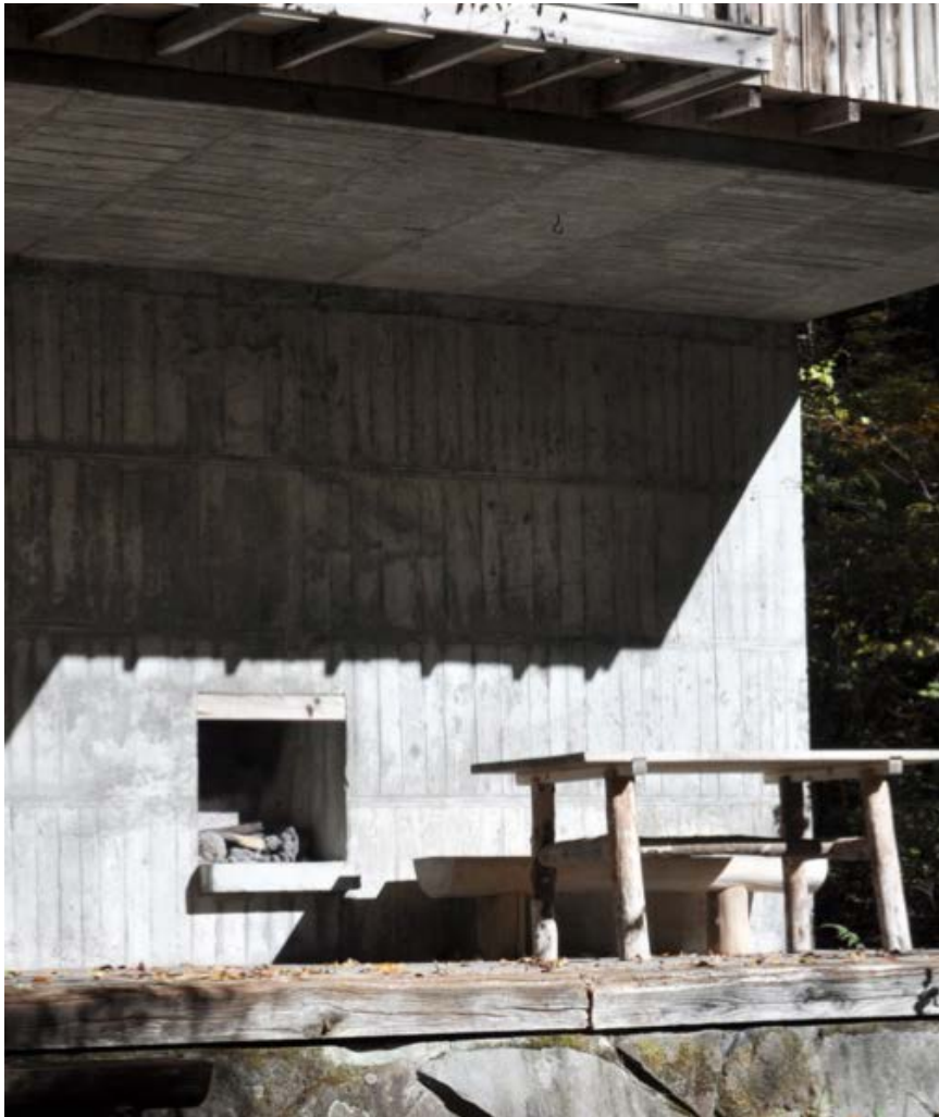
Figura 58. Chimenea exterior de la vivienda.
