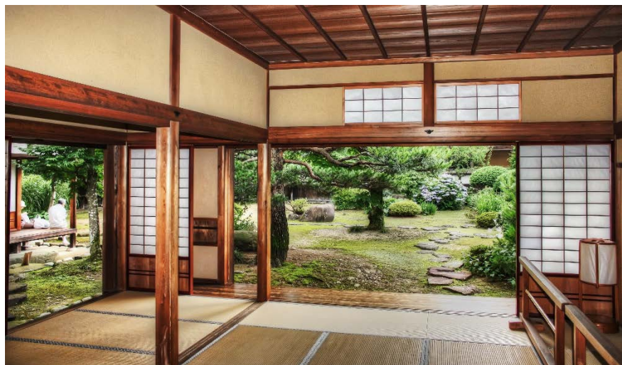
Figura 48. Dintel corrido ( nageshi ) sobre los shojis de una casa gubernamental del período Edo.
