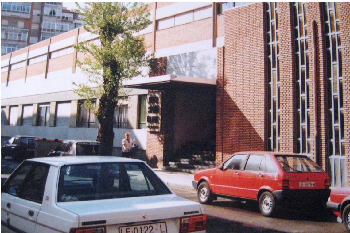
Fotografía 23. Fachada principal del Colegio San Juan de la Cruz (AGOCD).
