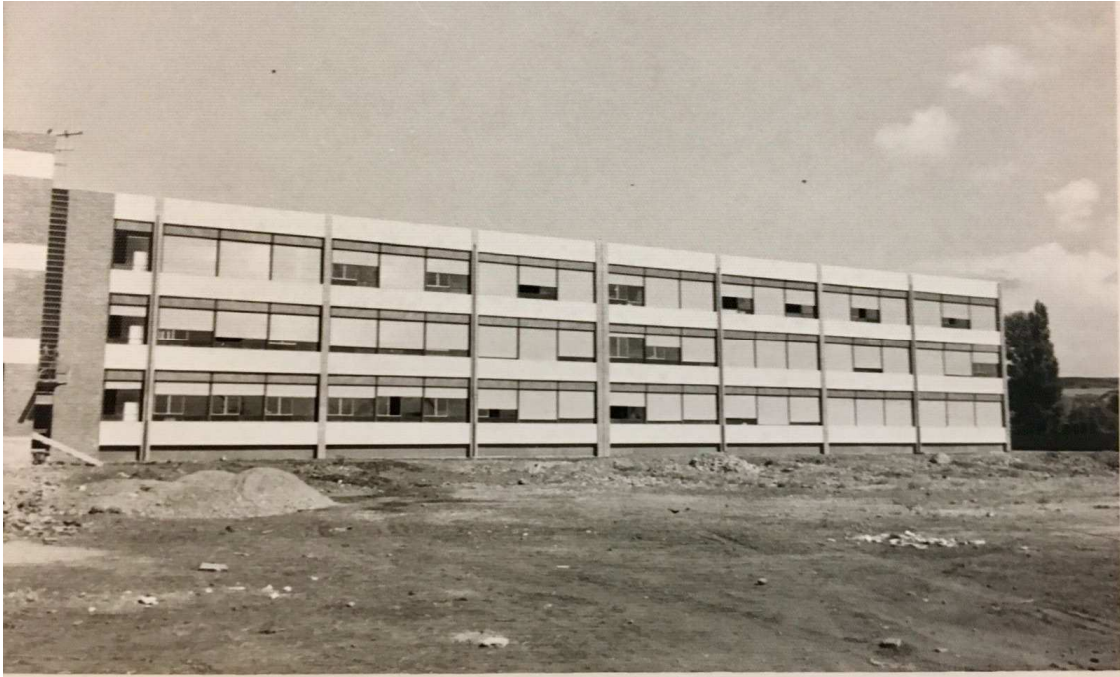
Fotografía 29. El patio del Colegio San Juan de la Cruz sin asfaltar (ACSJC).
