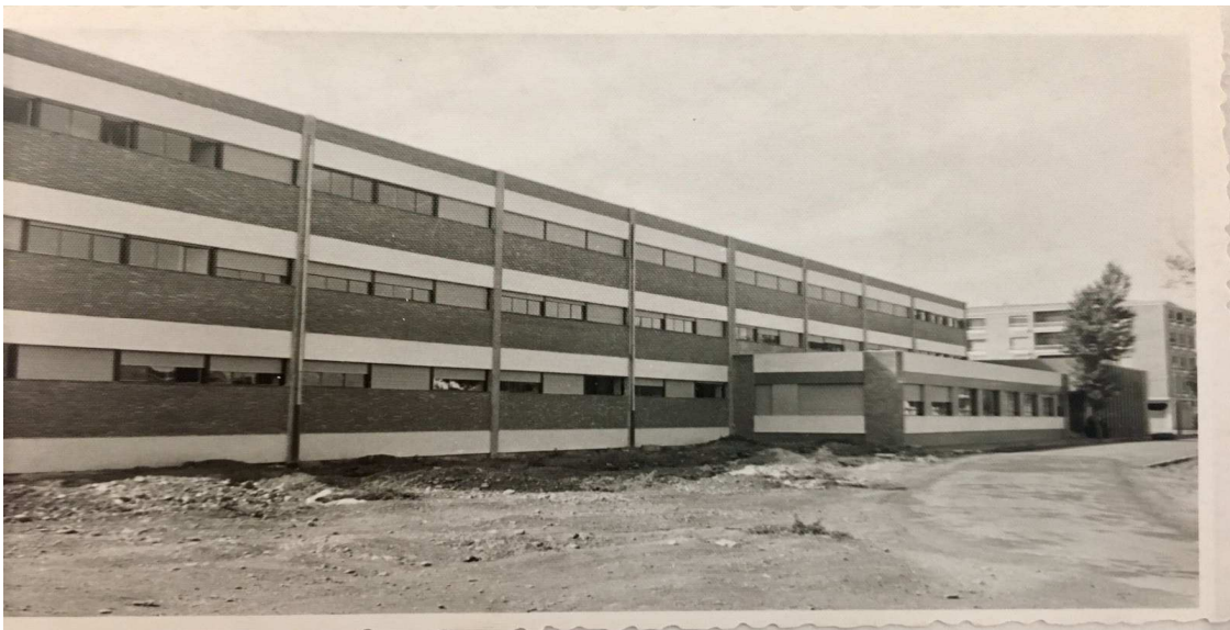
Fotografía 28. Colegio San Juan de la Cruz en construcción (ACSJC).
