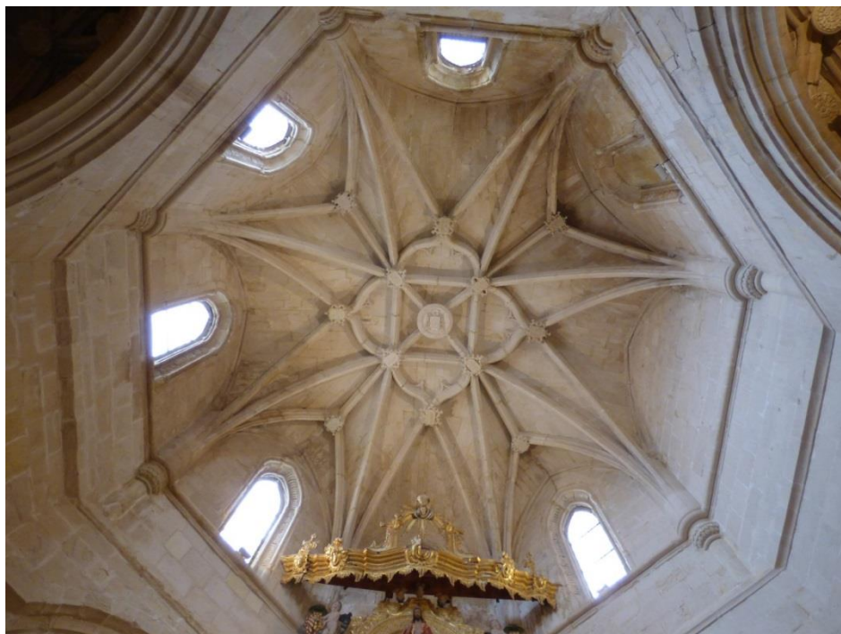
25. Cúpula de la capilla de la Asunción. Imagen propia.
