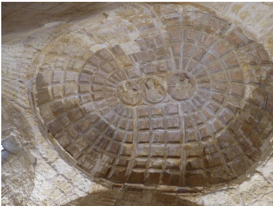
29. Cúpula de la sacristía. Capilla de la Asunción. Imagen propia.
