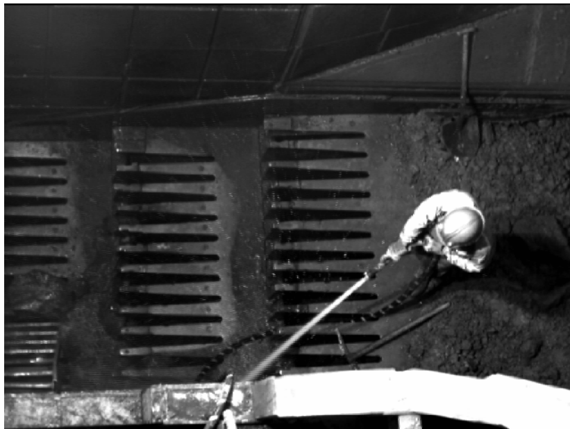
Figura 3.2. Empleado en el interior de la tolva.
