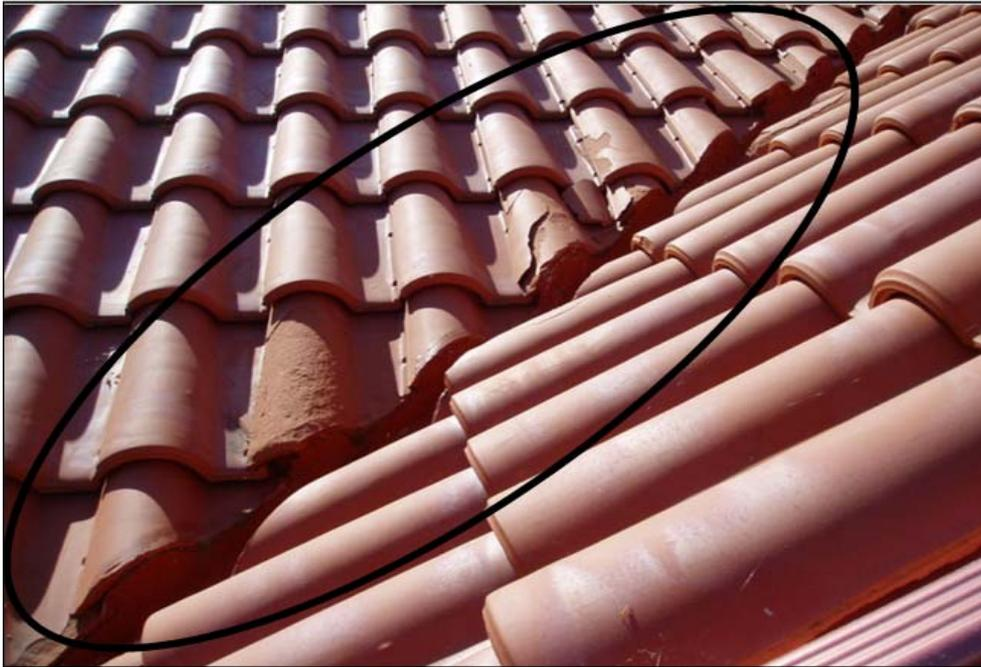
Figura 5-28: Tejas modelo M3 colocadas en Eto La Cañiza, daño en limahoya
