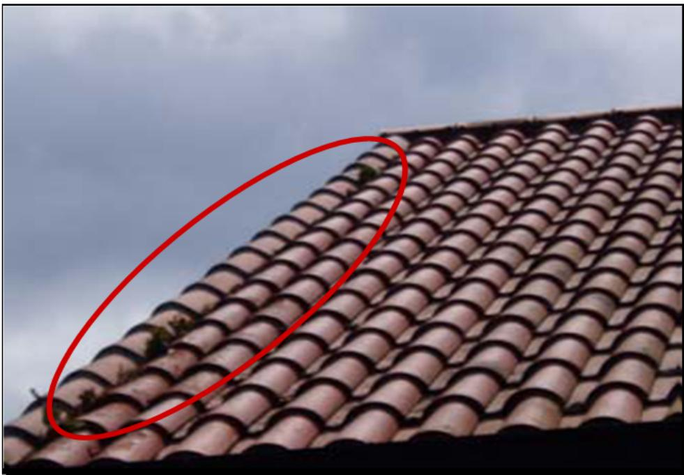
Figura 5-29: Tejas modelo M4 colocadas en Ávila, daño en hastial
