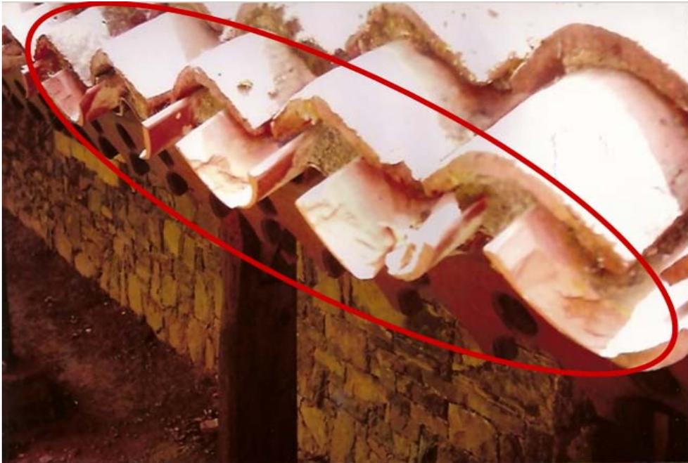
**Figura 5-31: Tejas modelo M5 colocadas en Potes, daños en alero**
