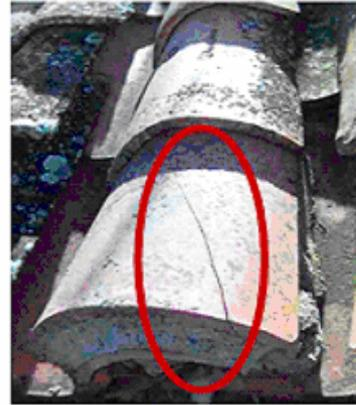
**Figura 5-32: Tejas modelo M6 colocadas en Sigüenza, daños en alero**
